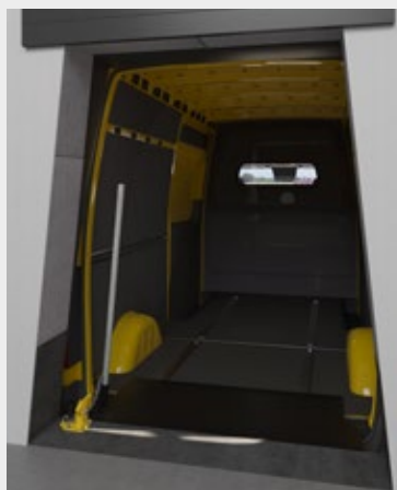
Überladebrücken vom Lagerinneren aus gesehen
