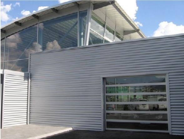
Das innovative SCHNEIDER Panoramator ist außergewöhnlich dadurch, dass die Sektionen **keine vertikalen Zwischenstreben haben**, wodurch eine breite Glasansicht möglich wird.
